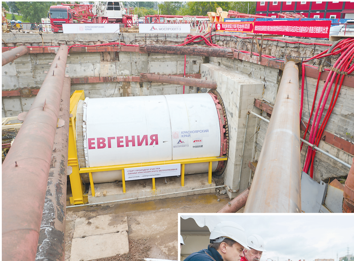
Комплекс «Евгения» должен пройти более 2,6 км под землёй.
