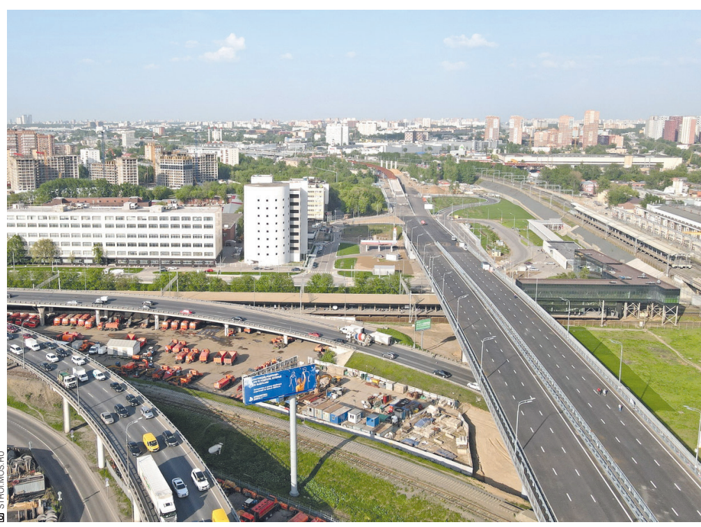
Строительство путепровода через ж/д пути на участке ЮВХ от ТТК до Новохоловской улицы
