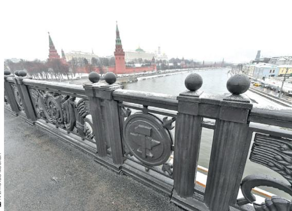
Новый тротуар с отстранированными чугунным ограждением на Большом Каменном мосту
